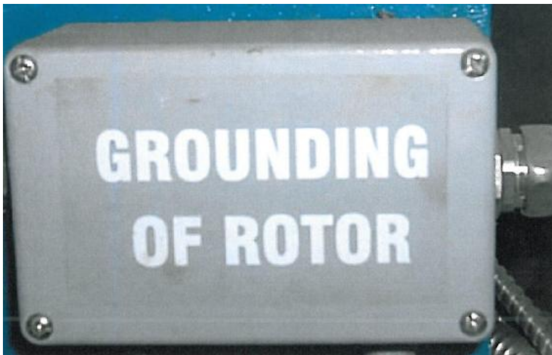
Obr. 1-2 – Svorkovnicová skříňka MX1
